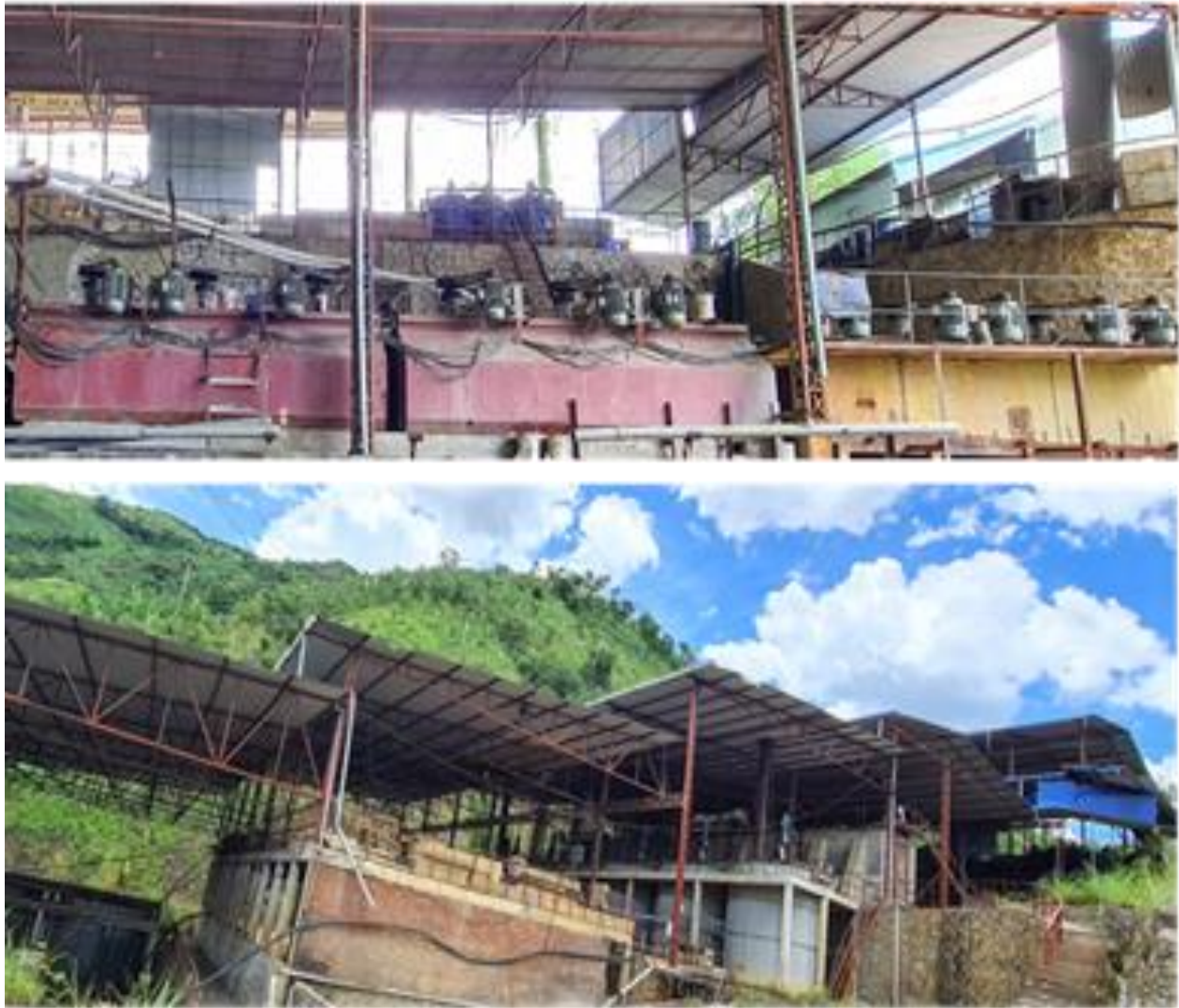
Hình 2. Nhà máy chế biến quặng đồng thuộc Công ty Cổ phần Khoáng sản Tây Bắc..
